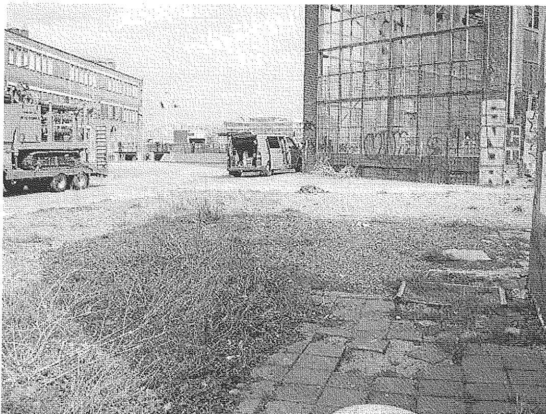
noordwest zijde (4 ondergrondse tanks)
