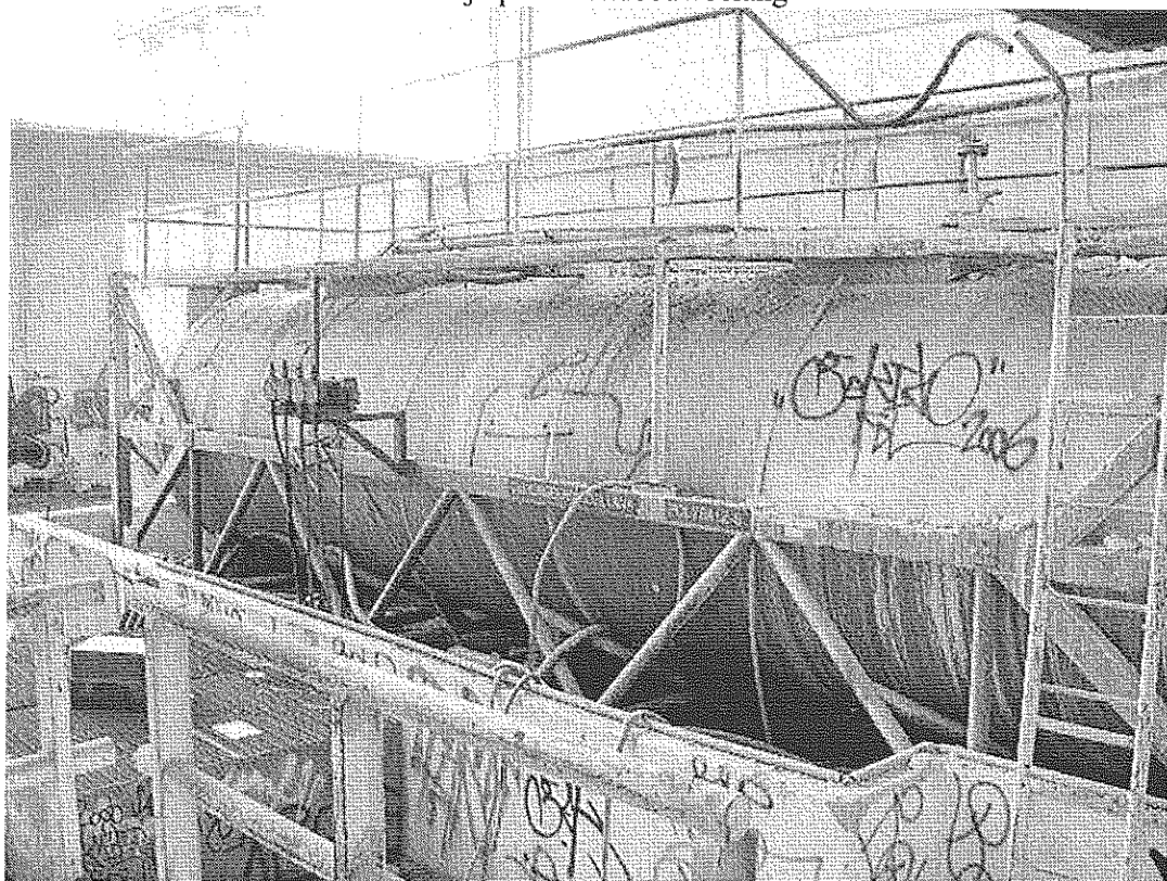
bedrijfspand SAPPI (voormalige kleibunkers)
